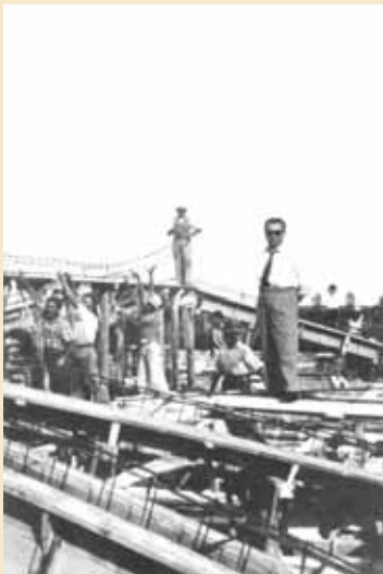
Il Cav. Giuseppe Tieni (con gli occhiali da sole) nel cantiere della Chiesa Ca’ degli Oppi costruita tra il 1952 e il 1953 dalla Tieni costruzioni
