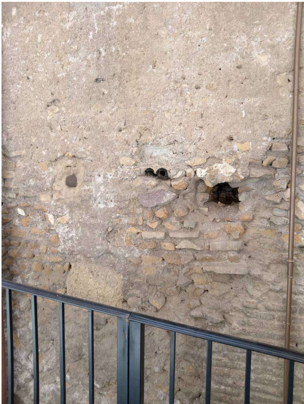
Illustrazione 19: Prospetto Est - Particolare della malta disgregata e delle porzioni di intonaco e cavità.
