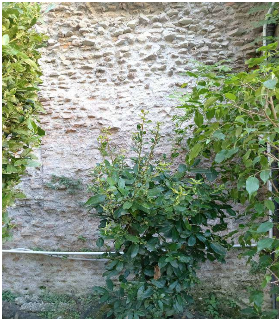
Illustrazione 12: Prospetto Nord - Particolare della decoesione del sacco del muro,
