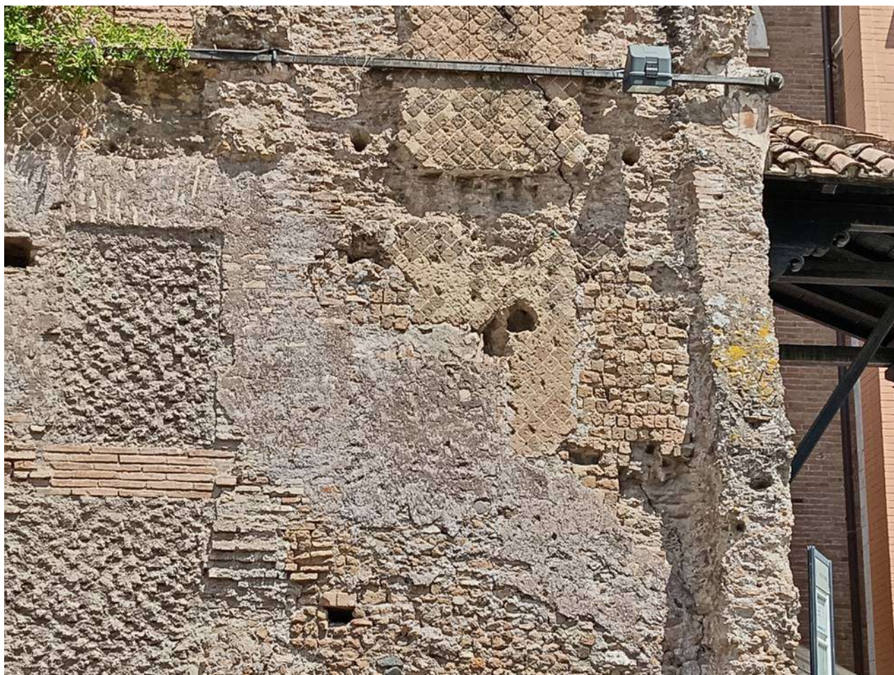
Illustrazione 8: Prospetto ovest - Vari tipi di paramenti murari interessati da fenomeni di abrasione e mancanza di stilature.
