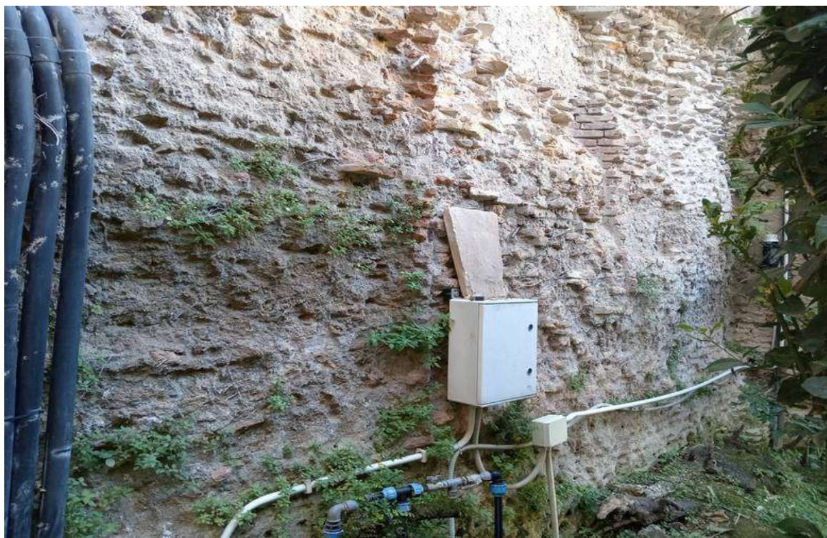
Illustrazione 15: Prospetto Nord - Particolare dei biodeteriogeni (patine e vegetazione superiore), e canaline degli impianti.
