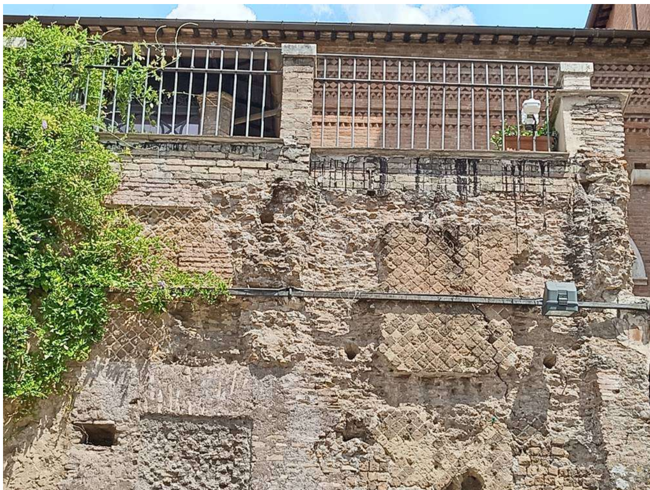
Illustrazione 7: Prospetto ovest - Particolare delle alterazioni cromatiche dovute probabilmente a colature di guaina liquida.
