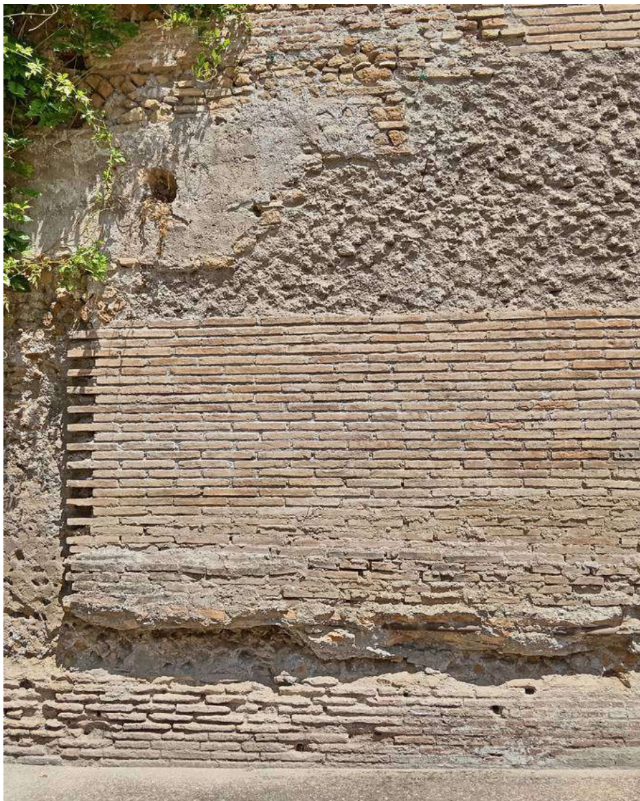
Illustrazione 9: Prospetto ovest - Il paramento murario interessato da patine coerenti e incoerenti. Evidente il sacco della muratura a vista, a causa della perdita del paramento stesso.
