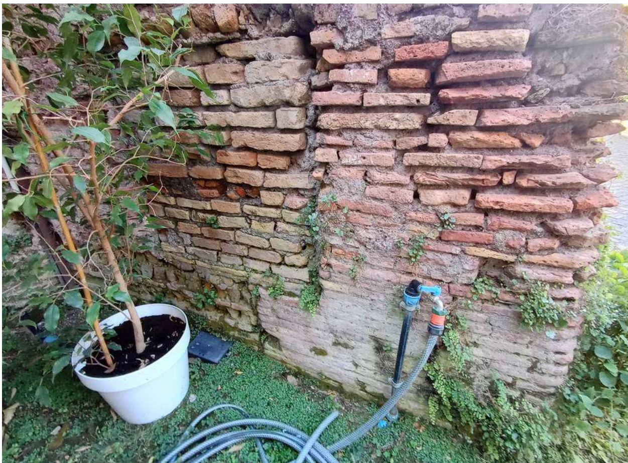
Illustrazione 14: Prospetto Nord - Particolar della mancanza delle stilature tra i mattoni e della presenza di biodeteriogeni (vegetazione superiore).
