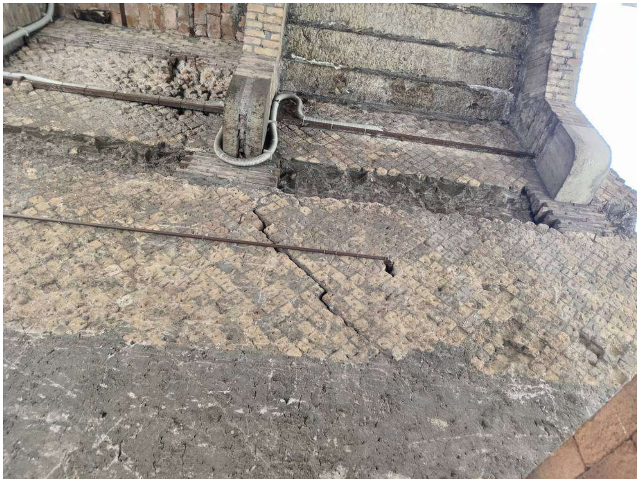
Illustrazione 20: Prospetto Est - Particolare delle fessurazioni che attraversano la muratura.
