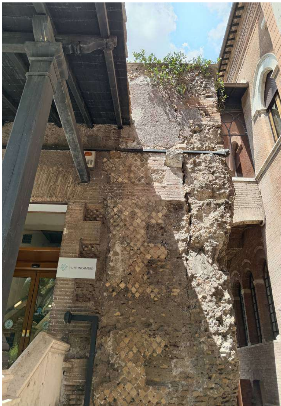
Illustrazione 2: Prospetto sud - Particolare delle murature adrianee interessate da fenomeni di abrasione. Evidente la frattura che attraversa la muratura.
