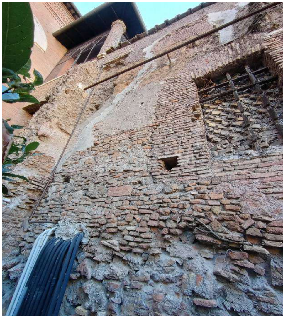
Illustrazione 13: Prospetto Nord - Particolare delle stuccature di cemento e presenza di canaline di impianti.
