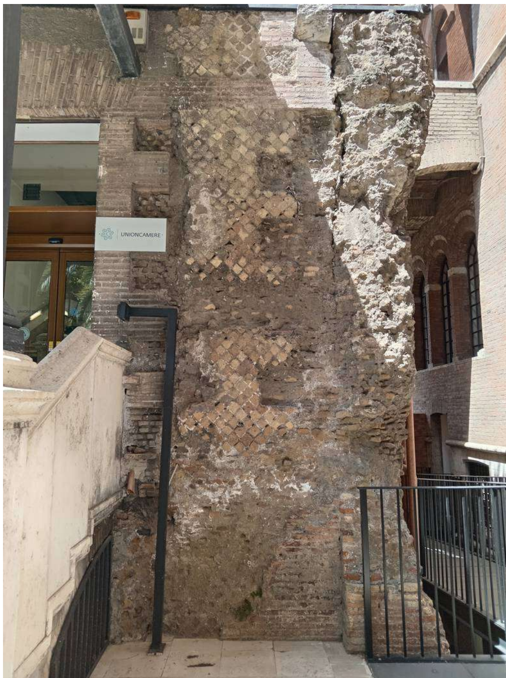
Illustrazione 3: Prospetto sud: particolare delle efflorescenze saline.
