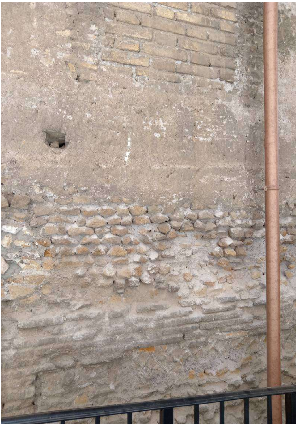
Illustrazione 18: Prospetto Est - Particolare dei depositi incoerenti e della disgregazione della malta del sacco del muro.
