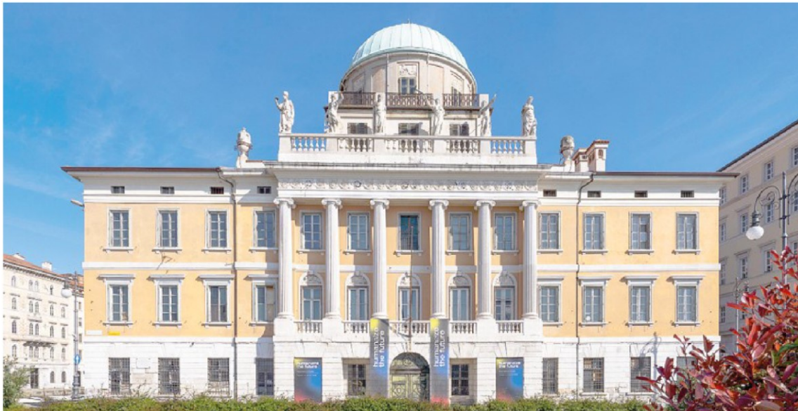
La sede. L'hub troverà sede nel Palazzo Carciotti, storico edificio in riva al mare
